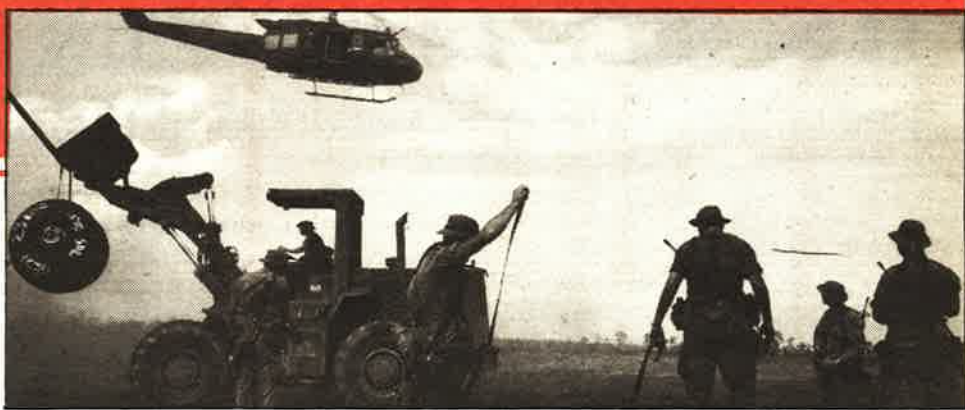
Pista de aterrizaje militar siendo construida por tropas estadounidenses en Honduras cerca de la frontera con Nicaragua, 1986.
